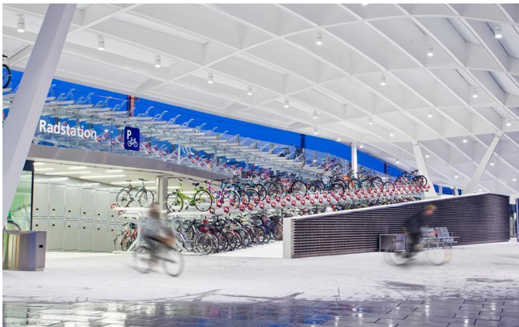
Fig. 18: Il nuovo bicipark, integrato nell'organismo architettonico di cui costituisce parte dell'affaccio a sud
