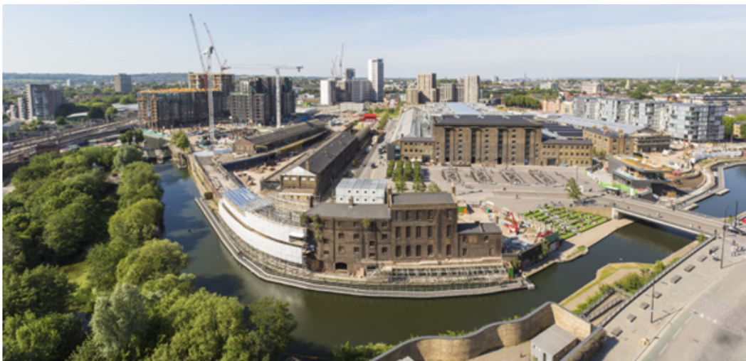
Fig. 40: Vista aerea del cantiere di rigenerazione di King's Cross
