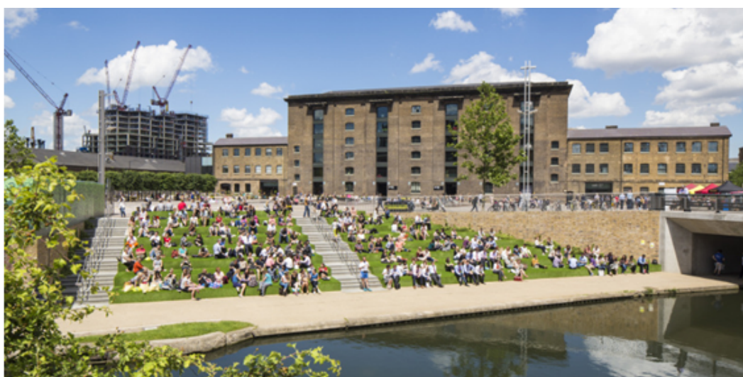
Fig. 39: Vista di Granary square, con lo storico Granaio insediato dall'Università delle Arti
