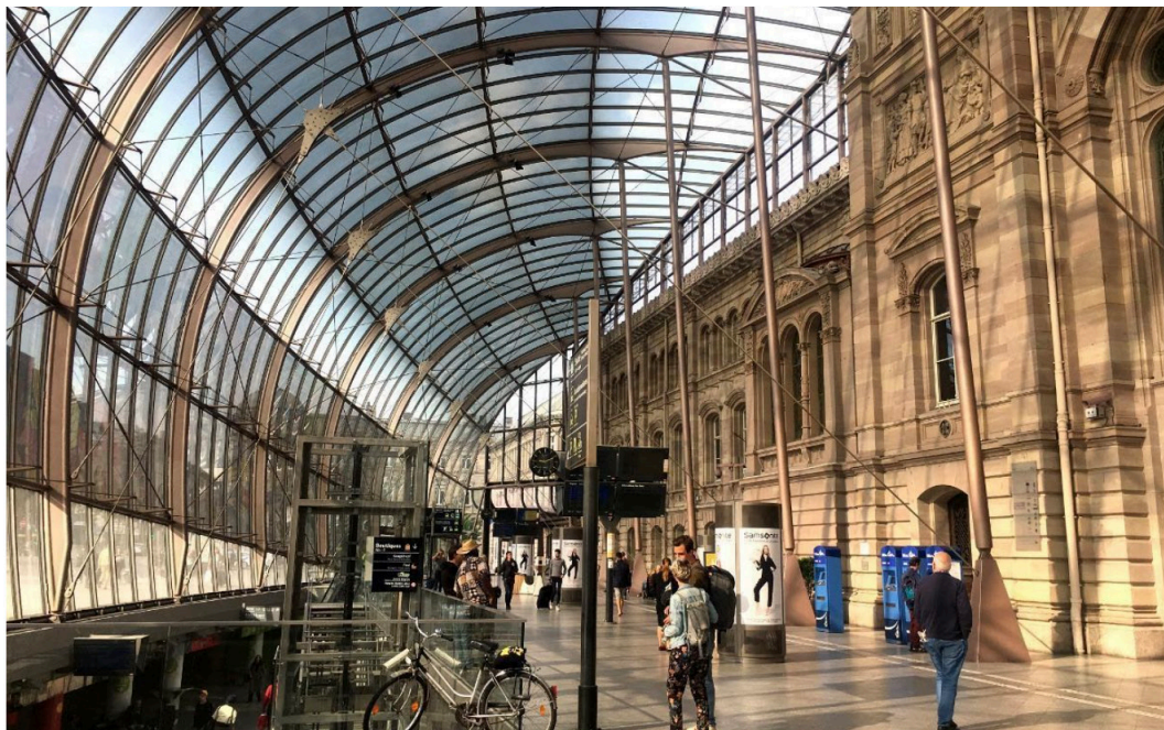
Fig. 20: La copertura vetrata della stazione di Strasburgo.
