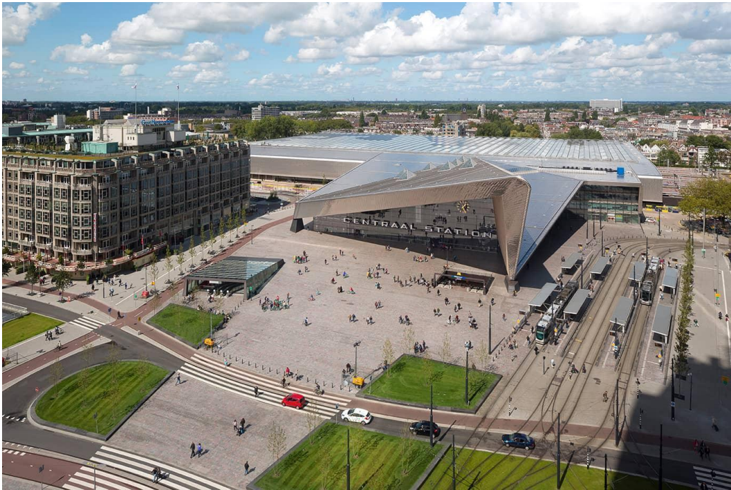
Fig. 11: Vista aerea della nuova Stazione Centrale e del piazzale antistante
